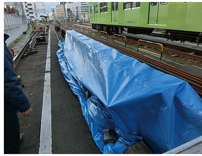
図11 レールの養生
