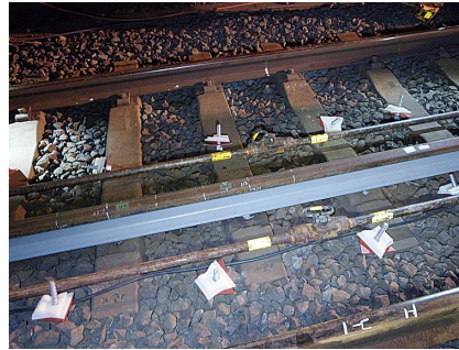
図12 営業線への敷設
