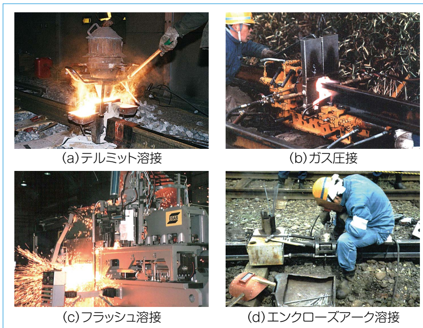
図1 レール溶接方法
