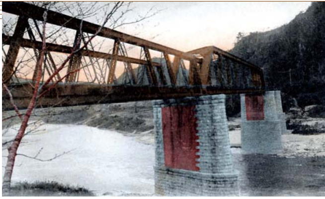
白石の設計により1897(明治30)年に完成した関西鉄道木津川橋梁(側径間の2連はランガー補強ののち現用中)
