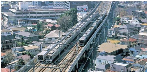
図1 複々線完成区間(経堂～千歳船橋間)
