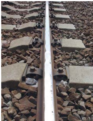
図1 レール波状摩耗の例
