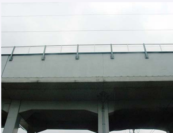
図3 ポリカーボネイト板による防音壁のかさ上げ区間
