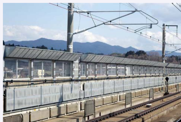
図8 先端分岐型防音装置 14) 提供: JR東日本
