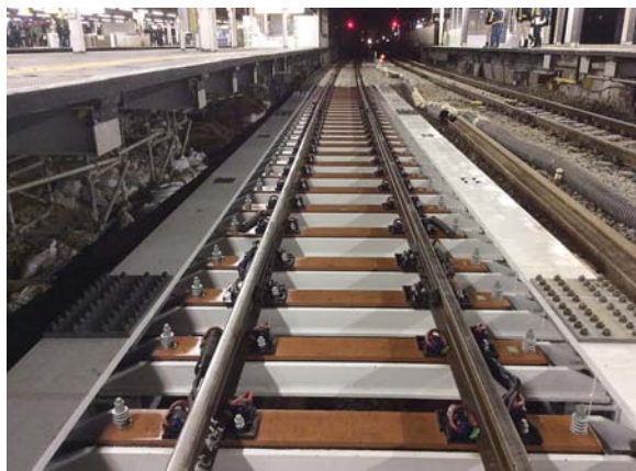
図1 工事桁工法
