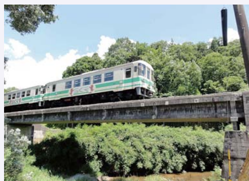
図1 信楽高原鐵道 第1大戸川橋りょう
