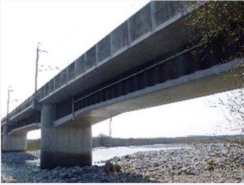
図3 北陸新幹線 黒部川橋りょう
