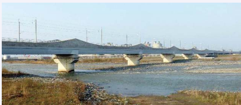
図2 北陸新幹線 姫川橋りょう
