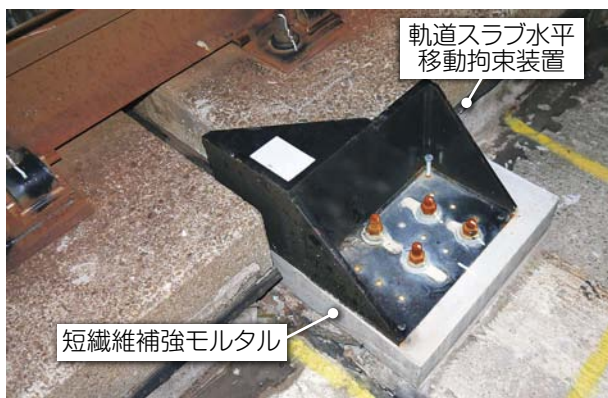
図7 軌道スラブ水辺変位拘束装置の設置状況
