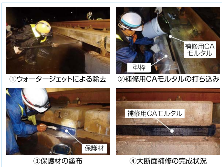
図11 大断面補修の施工状況
