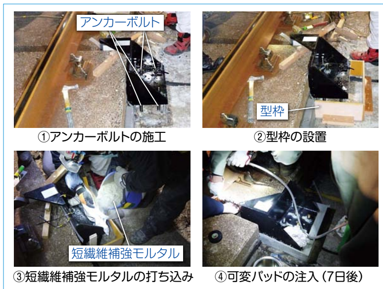
図6 軌道スラブ水平移動拘束装置の施工状況
