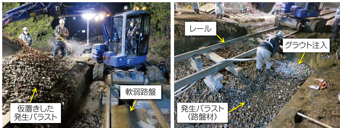
図10 発生バラストを再利用する路盤改良工法(グラウト充填工法)の施工状況
