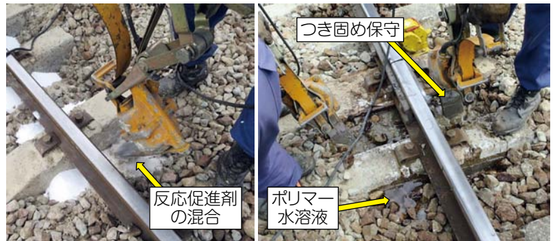
図4 ポリマー安定処理工法の施工状況
