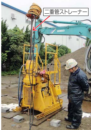
図5 注入試験の状況
