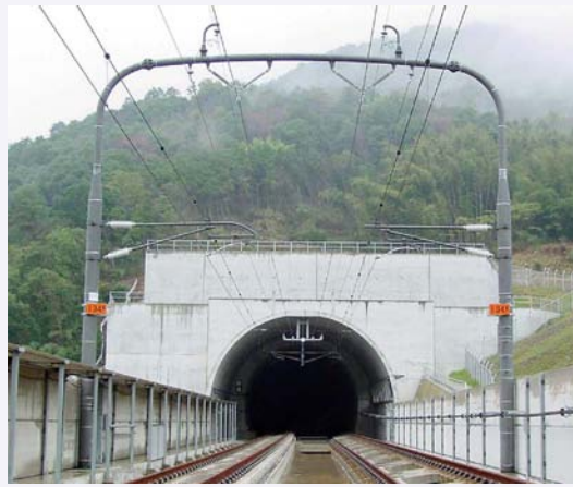
図8 金属の素材感を抑えた鋼管製支持物 7) 出典：電気学会技術報告，第984号
