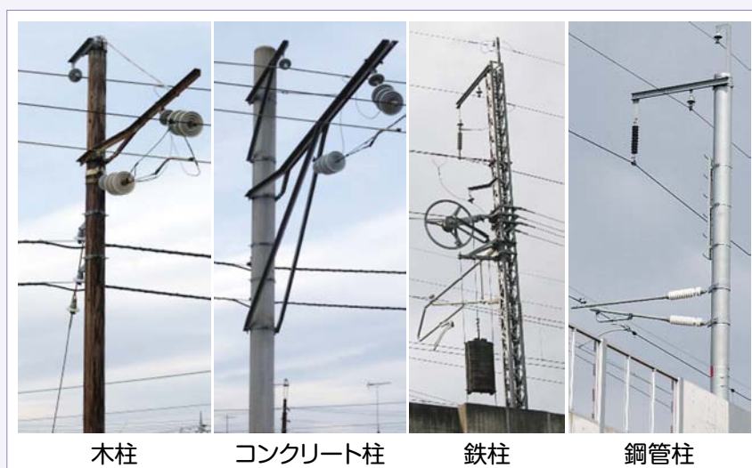
図2 電車線用電柱の種類
