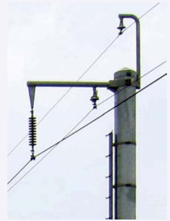
図9 支持物の雪害防止対策
