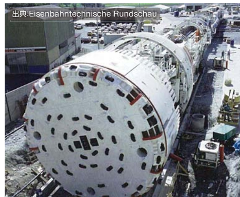
Niedergesteln坑口で編成作業中のトンネルボーリングマシン
