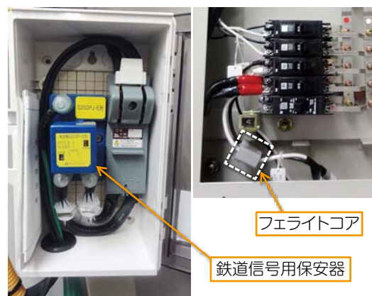
図 提案した遠制装置への雷害対策手法
