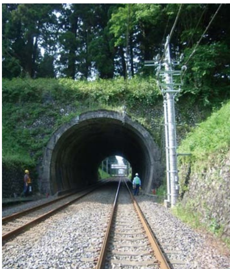
図1 十石坂トンネルの全景
