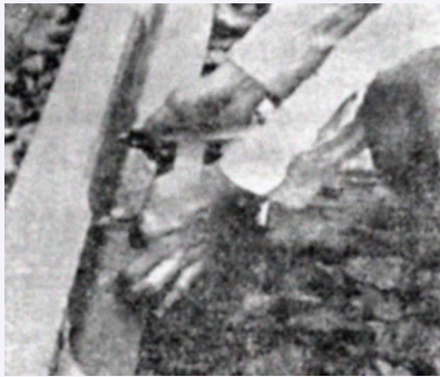
図3 ダイアルゲージによる軸力測定 1) 出典：伊地知堅一，ロングレール作業，鉄道現業社，1963
