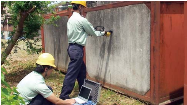
図3 総研式打音検査装置の使用状況
