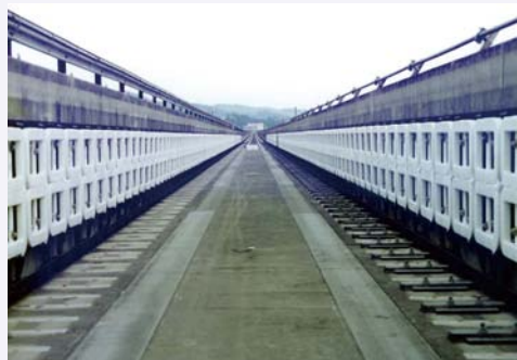
図9 側壁浮上コイルのプロトタイプの数設状況
