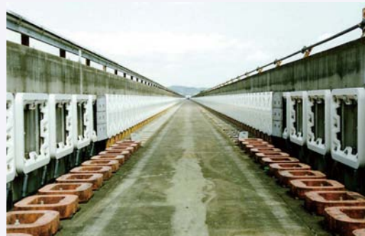
図10 宮崎実験線の対向浮上方式から側壁浮上方式への切り替わり区間(手前:対向浮上方式, 奥:側壁浮上方式)
