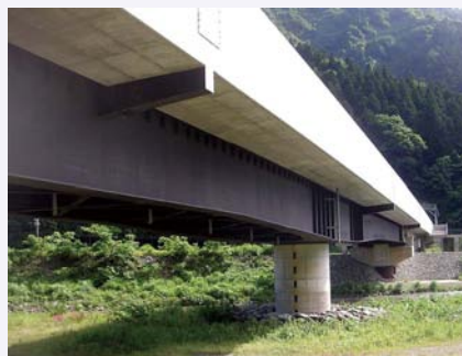
図9 北陸新幹線境川橋梁
