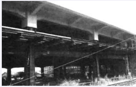
図3 軌道階打設後の山陽新幹線小倉東部高架橋(SRC高架橋、逆巻き工法) 出典：語り継ぐ鉄橋の技術、鹿島出版会発行、2008
