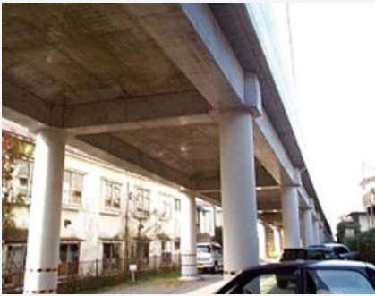
図5 秋田新幹線高架橋(CFT高架橋)
