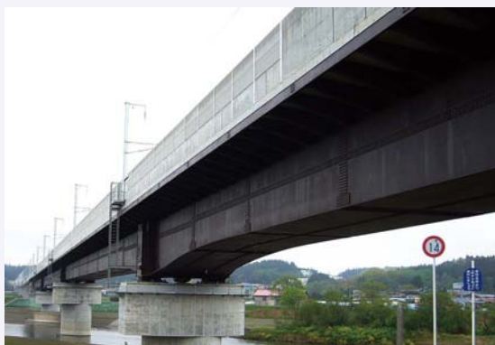
図8 東北新幹線奥入瀬川橋梁(合成桁) 出典：橋梁と基礎，Vol.45，No.4，p37，建設図書発行
