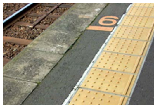
図7 ホーム縁端警告ブロック (←線路側 ホーム内側→)
