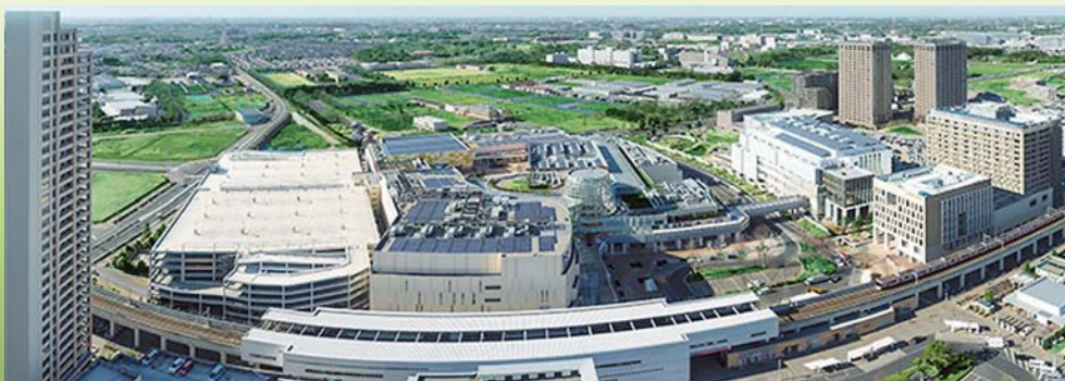
日立による電力融通の事例 (柏の葉スマートシティ)
