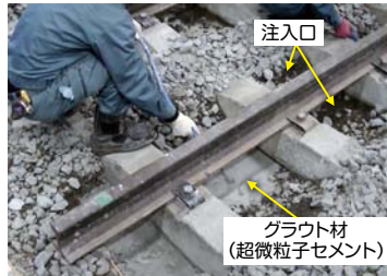
図1 グラウト材の注入状況
