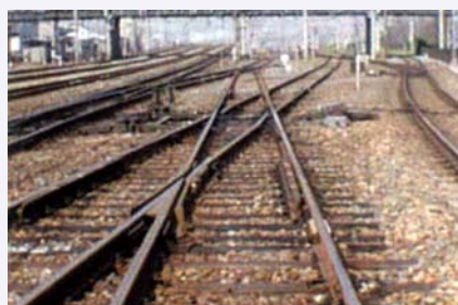
図2 ダイヤモンドクロッシング
