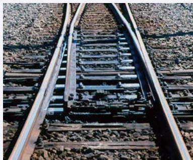
図8 Nレール用分岐器のポイント 図9 ノーズ可動クロッシング
