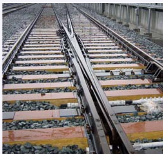
図8 Nレール用分岐器のポイント 図9 ノーズ可動クロッシング
