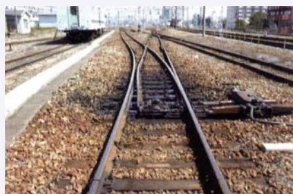
図1 片開き分岐器
