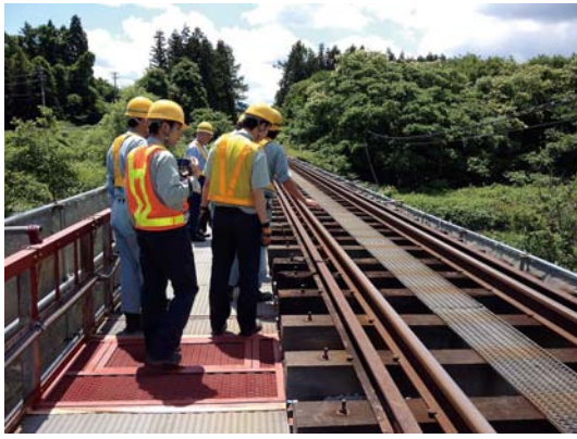
橋りょうの現地調査
