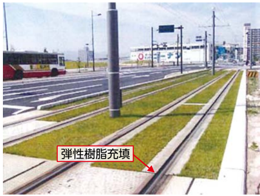
樹脂固定軌道
