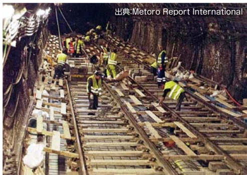
バラストを撤去して露出した分岐器部の軌道
