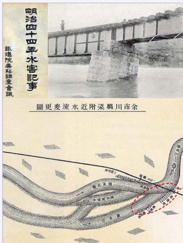
図1 「明治44年水害記事 1) 」とこれに掲載された函館本線然別・仁木間余市川橋りょうの被災状況
