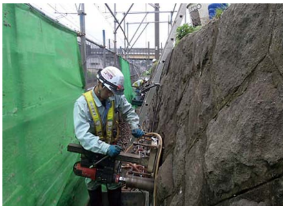
図1 削孔状況
