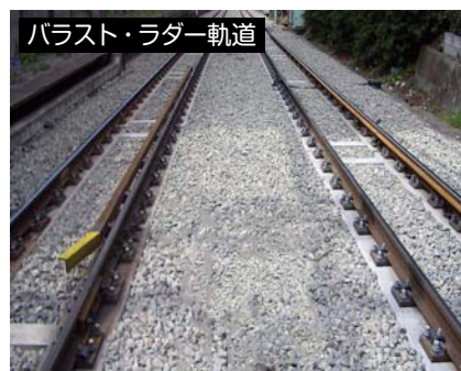
図7 バラスト・ラダー軌道の敷設例
