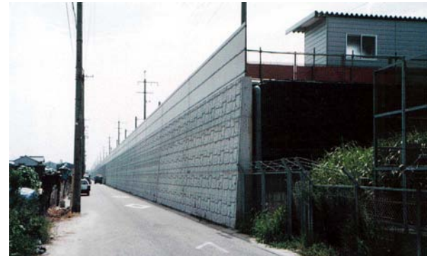
図4 名古屋車両基地での施工例
