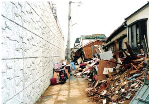
図5 兵庫県南部地震での被災状況
