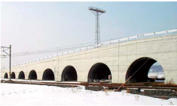
図8 補強土アーチの施工例
