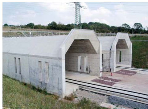
図4 ドイツの70m緩衝工
