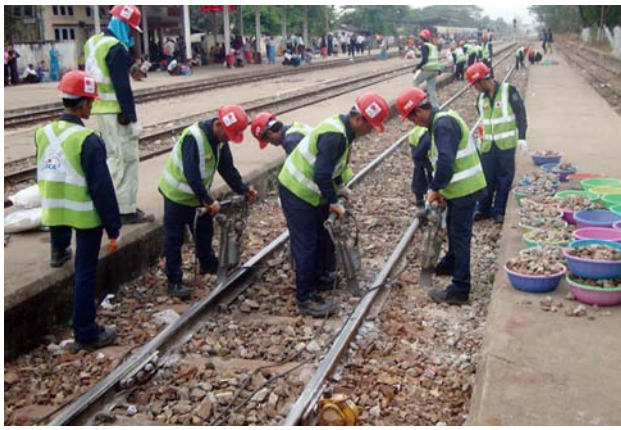
図2 突き固め作業
