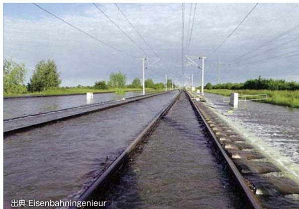
2013年6月に発生した軌道路盤の水没
