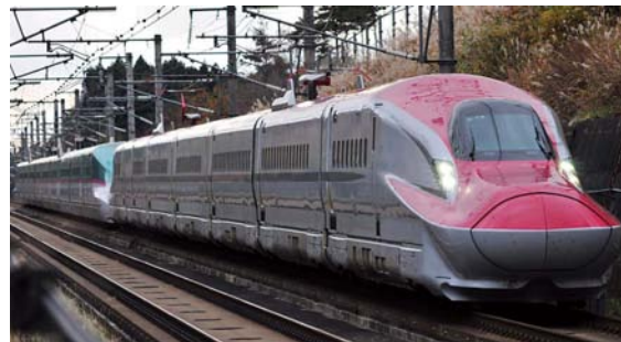
図3 電動機械式左右アクティブサスペンション搭載車両例:JR東日本E6系(前方)・E5系(後方)【写真提供:JR東日本】
