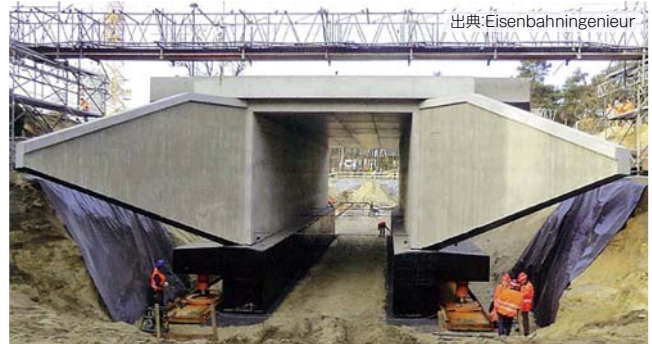
立体交差構造物の持ち上げ
