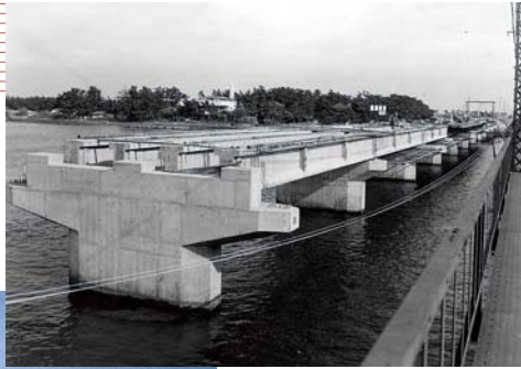
④ PCI桁を用いた施工中の東海道新幹線・第二浜名橋梁(1964)
