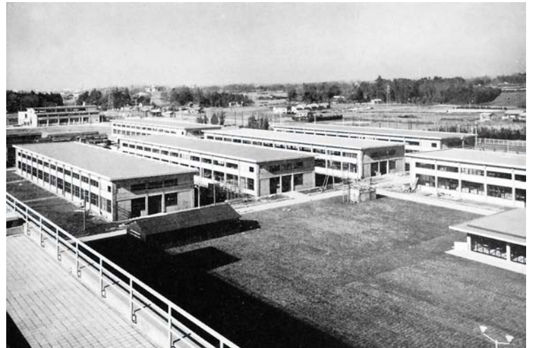
⑦ PC建築として完成した鉄道技術研究所実験棟(1960)
