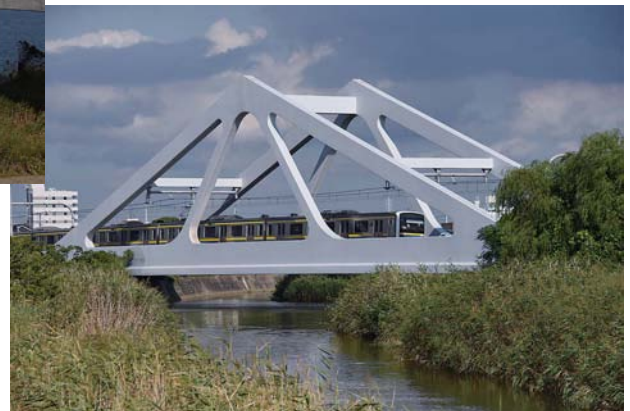
⑯PC斜吊橋として完成 した内房線・姉ヶ崎 川橋梁(2002)
