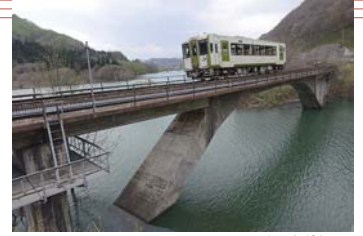
⑮方杖橋として完成した廻戸川橋 梁(北上線ゆだ錦秋湖～ほと ゆだ／1960)
