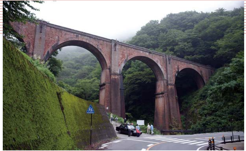
④煉瓦造最大のアーチ橋(旧信越本線横川～熊ノ平・碓氷第三橋梁／1893)
