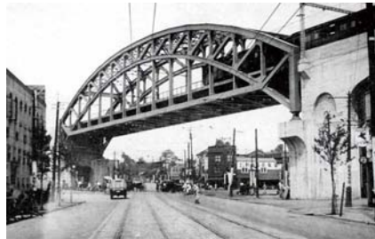
⑪タイドアーチによる松住町架道橋 (総武本線御茶ノ水～秋葉原 / 1932)
