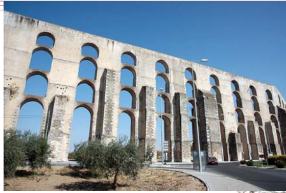
①中世の水道橋に用いられたアーチ構造（ポルトガル・アモレイラ水道橋／15～17世紀）
