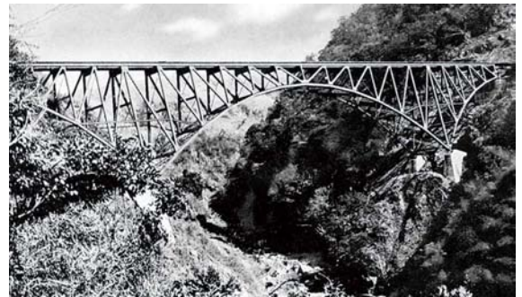
⑫バランストアーチによる第一白川橋梁 (南阿蘇鉄道立野～長陽 / 1927)
