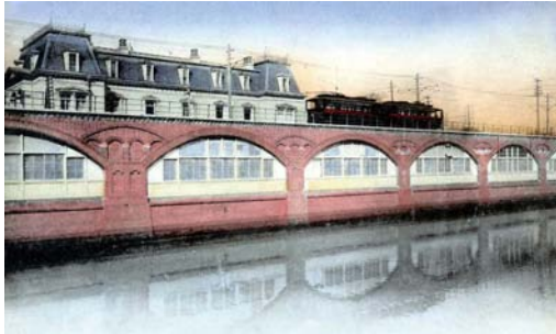
⑤煉瓦造のアーチ式高架橋（東海道本線有楽町～新橋・内山下町橋高架橋／1910）
