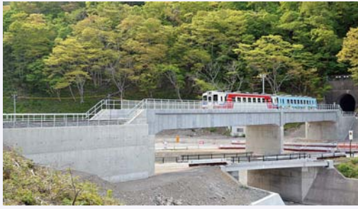
図5 三陸鉄道に採用されたGRS一体橋りょう
