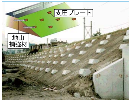
図4 地山補強材による既設盛土補強
