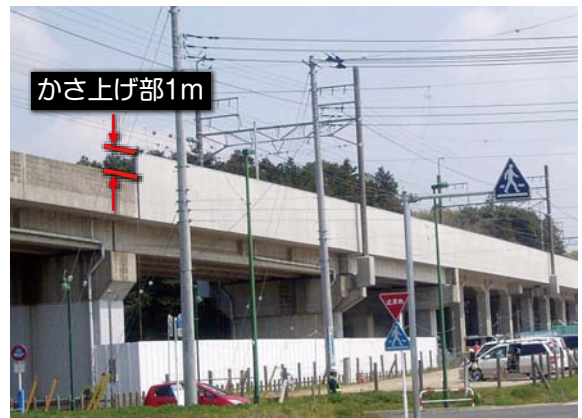
図11 ラーメン高架橋の高欄での施工例
