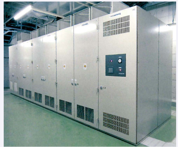
図9 つくばエクスプレスのPWM変換装置 (自励式整流器) 提供：首都圏新都市鉄道株式会社
