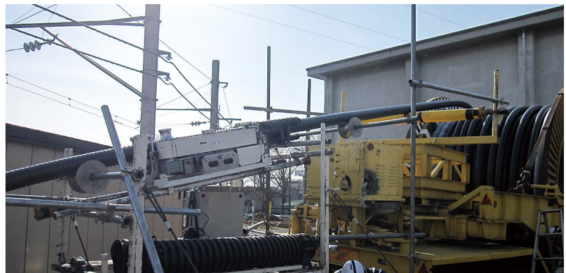
図6 300m級超電導き電ケーブルの延線の様子
