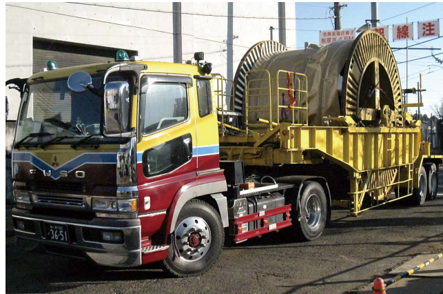
図5 300m級超電導き電ケーブルの搬送の様子
