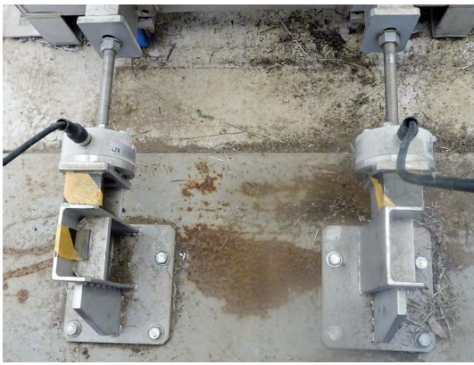
図3 電流末端部に設置した応力測定装置
