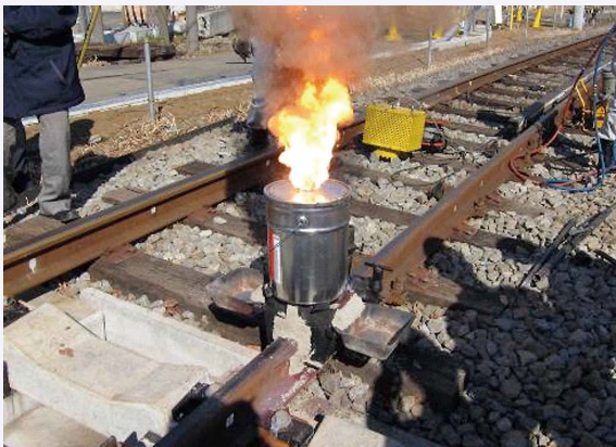
図9 THRによるシェリングきずの補修溶接
