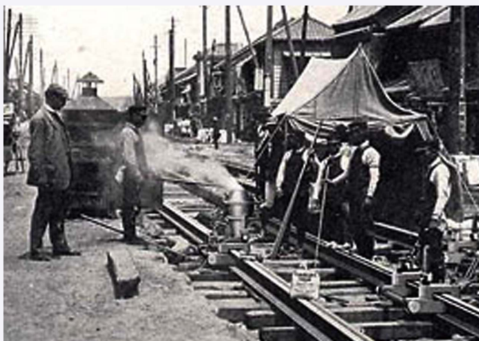
図2 テルミット溶接の施工状況(1909年当時) 出典：Goldschmidt-Thermit Japan社HP
