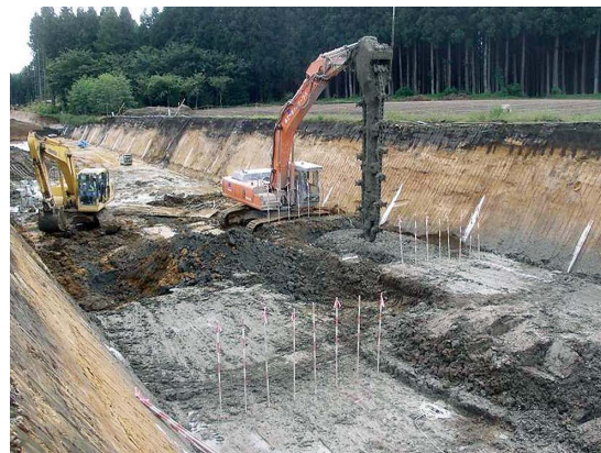
図3 事前地山改良工の施工状況
