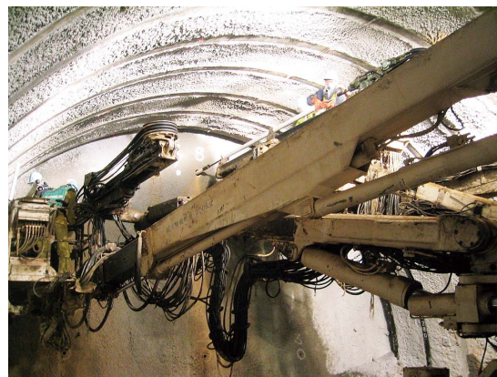
図5 長尺鏡ボルトの施工状況
