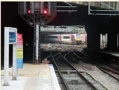
Birmingham New Street駅の複雑な配線
