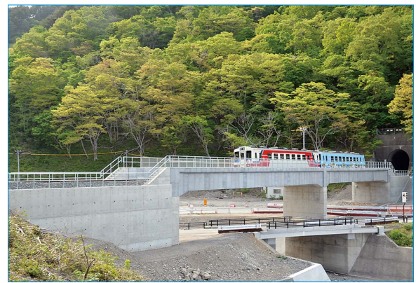
図13 ハイベ沢橋りょう (三陸鉄道・北リアス線)
