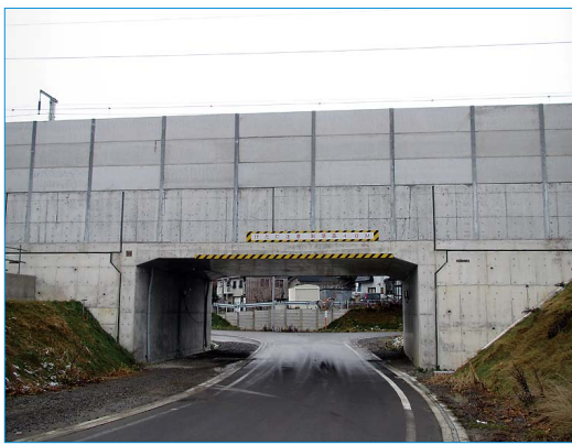
図12 木古内における補強盛土一体橋りょう (北海道新幹線)
