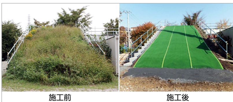
図 防護シート施工状況
