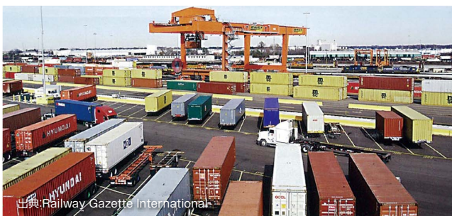
Memphisインターモーダル・ターミナルは2010年に大規模改修され、低炭素型のガントリークレーンを装備している
