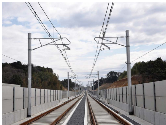
図6 き電ちよう架式コンパウンドカタナリー
