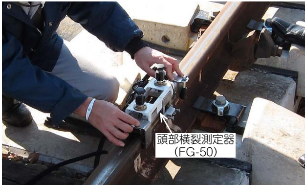
図2 レール頭部横裂探傷の状況
