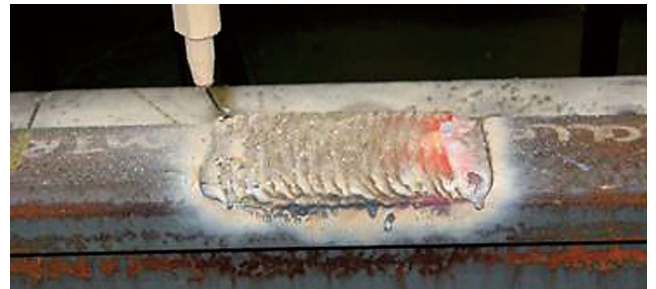
図4 半自動アーク溶接法 (海外)
