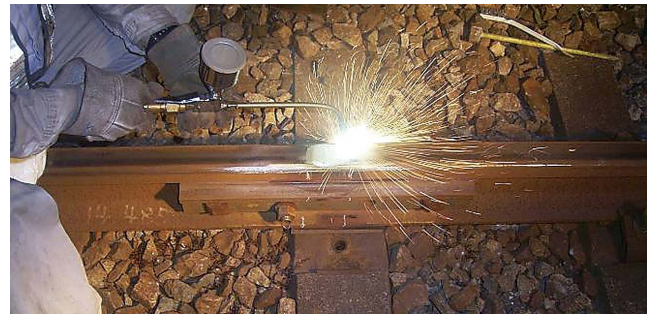
図3 ガス溶射肉盛法 (国内)
