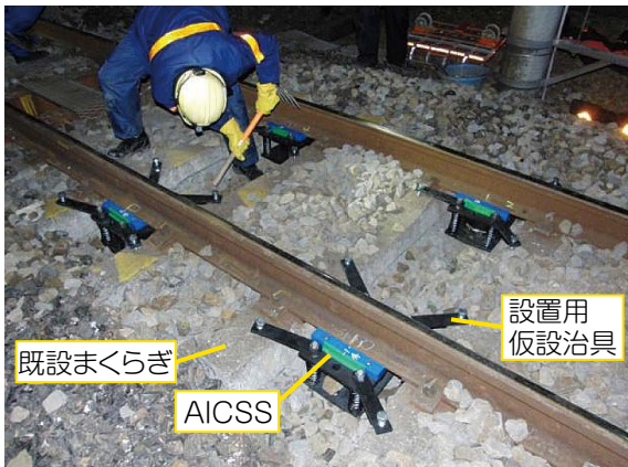
図10 営業線での施工状況
